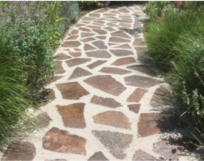
Sigillatura fughe di lastre poligonali
