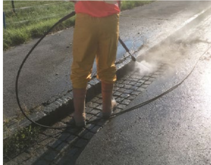
Pulizia della superficie con acqua o aria compressa
