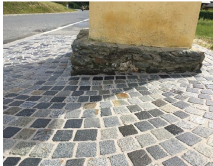
Struttura fuga dopo il risanamento
