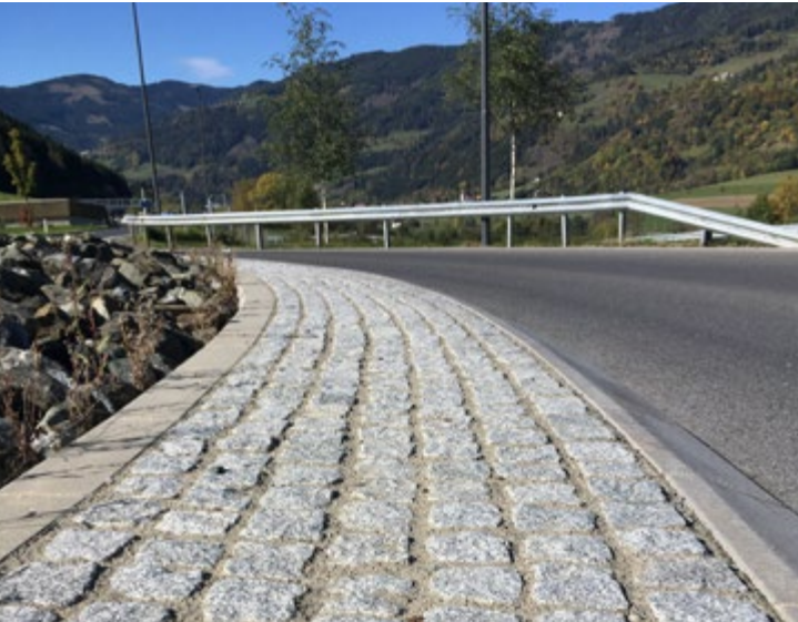
Sigillatura fughe di rotatorie
