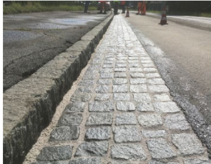
Canaletta di scarico risanata
