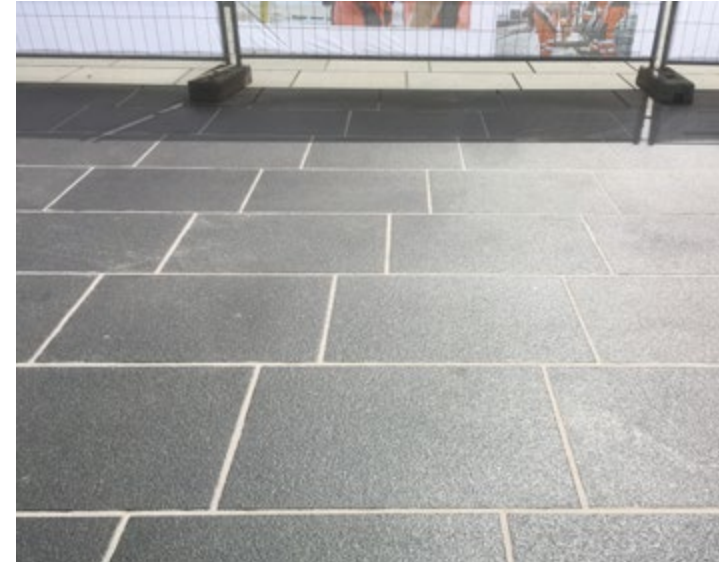
Riparazione di fughe in cemento danneggiate
