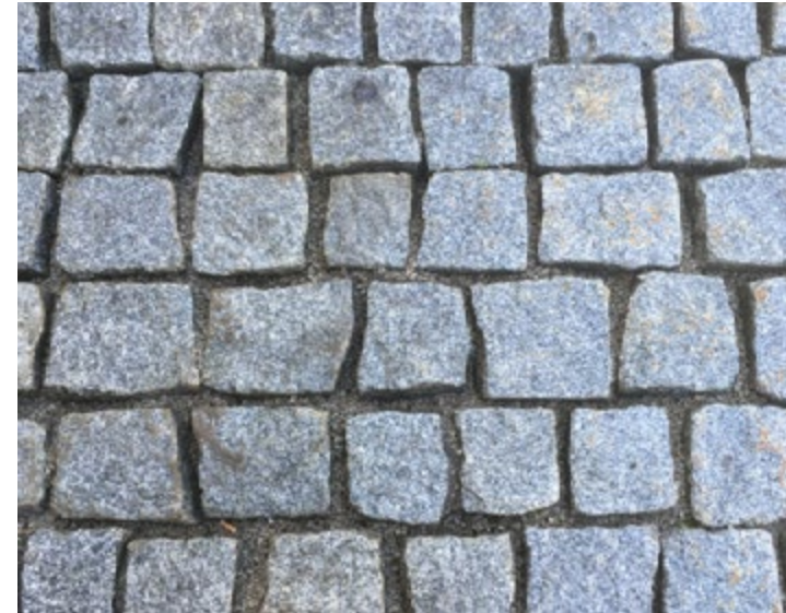
Piccola superficie in pietra prima della sigillatura fughe
