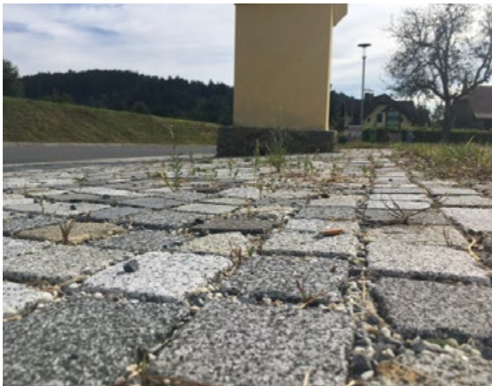
Struttura fuga prima del risanamento
