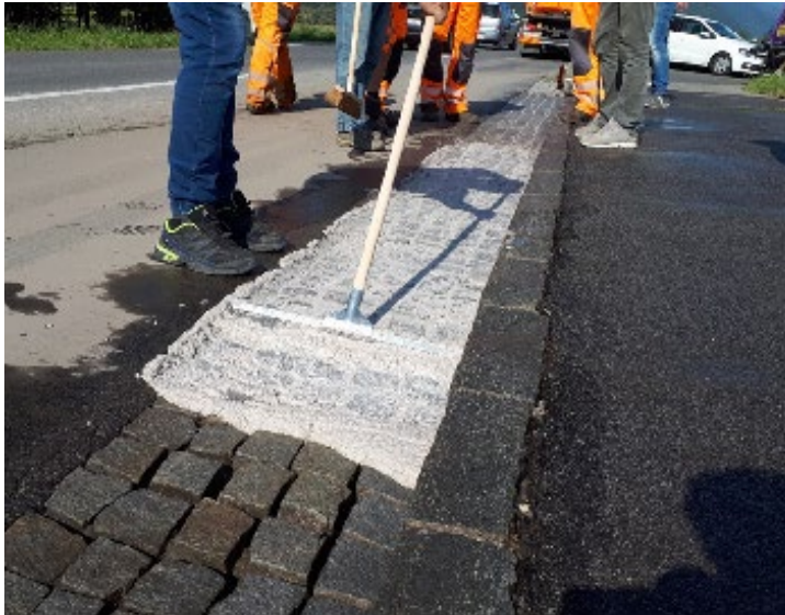
Sabbatura delle fughe in resina a reazione italopox®
