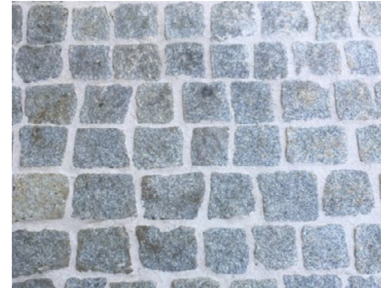
Piccola superficie in pietra dopo la sigillatura fughe con italopox®
