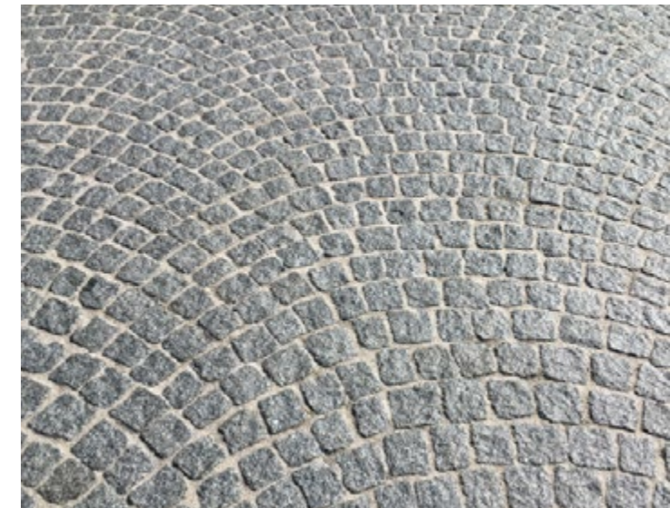
Sigillatura fughe di piccole superfici di selciato
